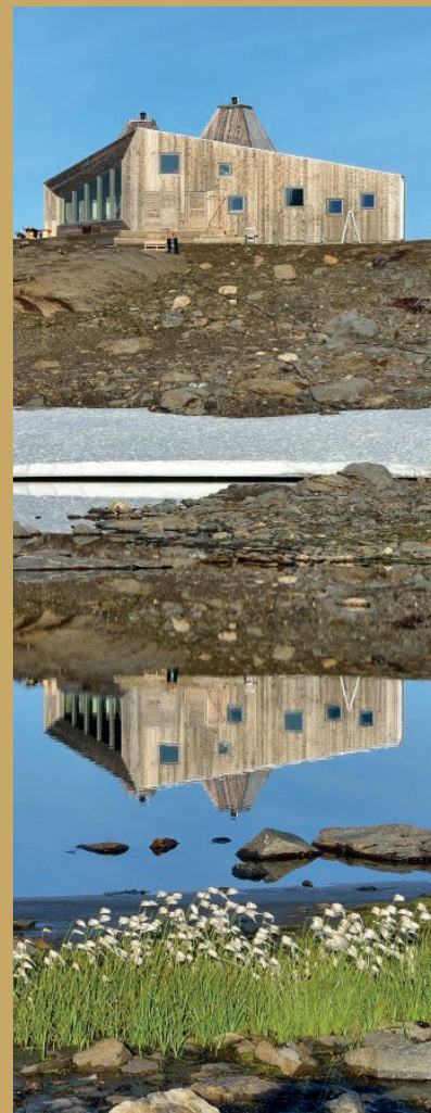
Rabothytta, som i 2016 ble tildelt Hemnes kommunes byggeskikkpris
