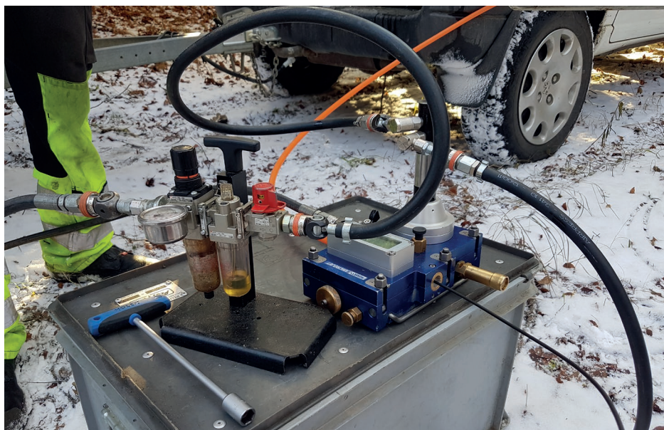
Arbeidet med legging av fiberkabel mellom Hattfjelldal og Korgen pågikk hele 2016. På bildet vises en del av utstyret som benyttes til å blåse fiberkabelen inn i trekkroret.
