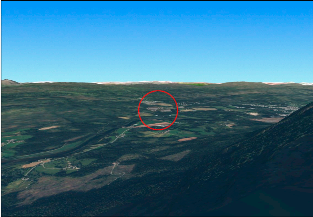
Figur 52: Ettersituasjon sett mot tiltaksområdet (innenfor rød sirkel) fra Storberget.
