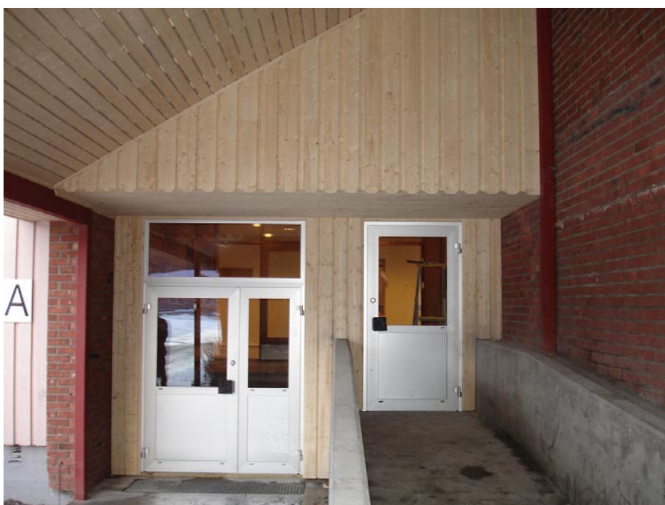
Rehabilitering inngangsparti ved Korgen sentralskole
