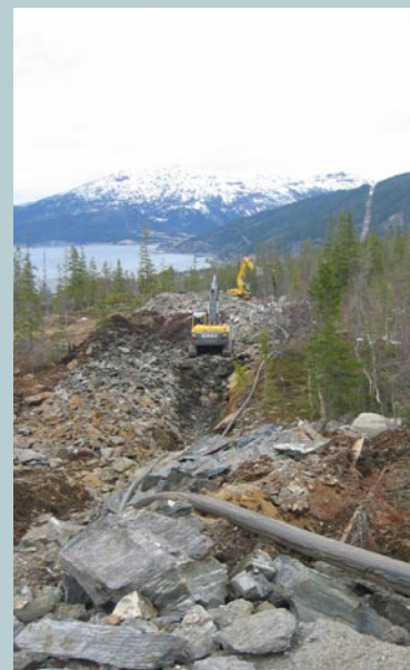
Vannledningsarbeid i Kangsliåga
