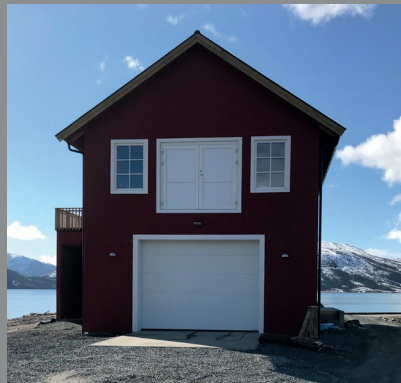
Det nye avlopsrenesanlegget på Hemnesberget som ble ferdig i 2017. Anlegget kostet ca kr. 2,2 mill. og ble satt i drift i september
