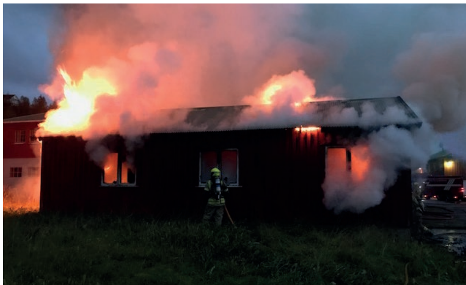
Fra en brann i lagerbygning på Bjerka
