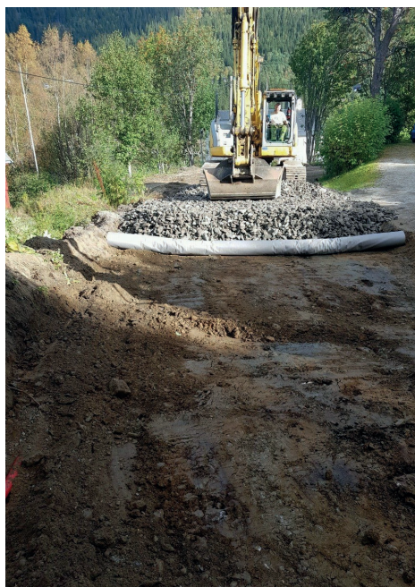
Fra renoveringen av Svalengsvegen som ble gjennomført i 2017 av firma Jobansen Maskin
