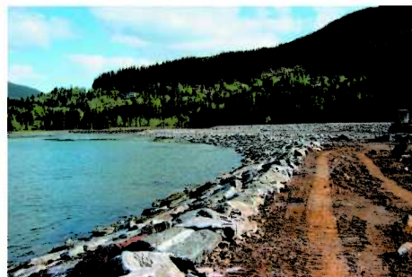
Planeringsarbeider på fyllingen i Finneidfjordfjæra
